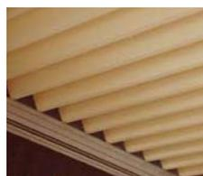
スチールガルバリウム折板にペフを張り付けた仕様です。天井から結露が落ちてくるのを緩和します。(色は1種のみ)
