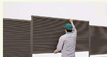
本体を上からスライドして柱に差し込み、柱キャップを取り付けます。
