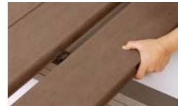
③横止め金具に引っ掛けるようにして次の床板をはめ込みます。
