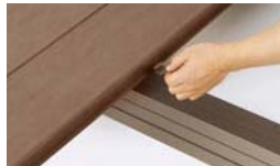
①横止め金具を床板に当てるようにセットします。
