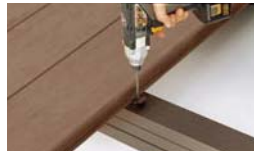
②大引に横止め金具を固定します。
