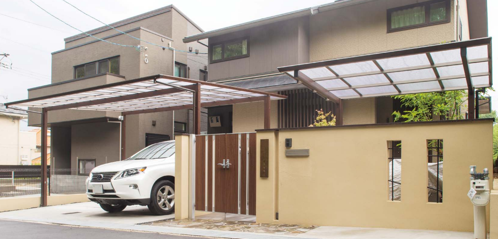
2種類のアートポートを使用。建物や植栽の緑とも調和し、全体的に落ち着いた雰囲気仕上りました 【アートポートミニ 21-28 クリアマットポリカ ダークパイン ▶P.148】【アートポートワイド クリアマットポリカ ダークパイン ▶P.150】
